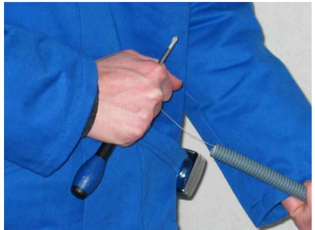
8. Il est possible maintenant de tracter l'aiguille en l'ayant au préalable accrochée à un tournevis (Remarque : Il est préférable d'être à deux pour cette étape, un qui tire sur l'aiguille et l'autre qui fait attention à ce que les conducteurs ne se croisent pas lorsqu'ils pénètrent dans la gaine).
