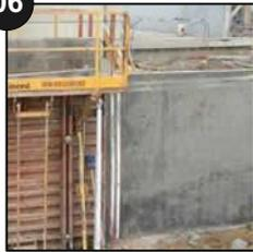
Mur en béton banché avec la banche
