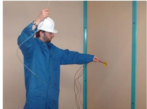
7. Tirer sur l'aiguille côté tête flexible en essayant de guider et pousser du côté des conducteurs à enfiler.
