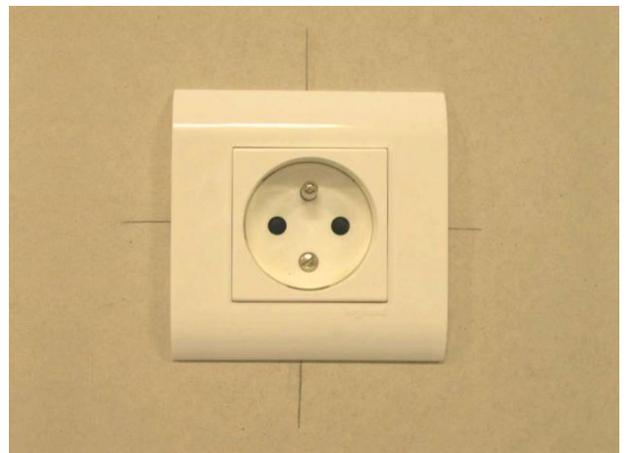
6. Pour finir, mettre les accessoires de finition, si nécessaire, et terminer par la pose de la *plaque* de l'*appareillage* électrique.
