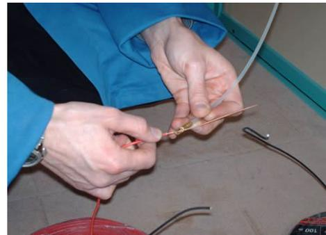
2. Enfiler le *conducteur* ainsi dénudé dans l'oeillet en laiton de l'*aiguille* (pour éviter une surépaisseur, s'arrêter à 1 cm de l'isolant).
